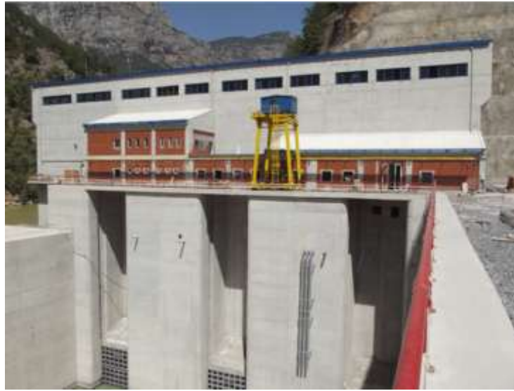
Ana Santral Binası Görünümü... 2009 .... [ DOLSAR MÜH. LTD. ]
