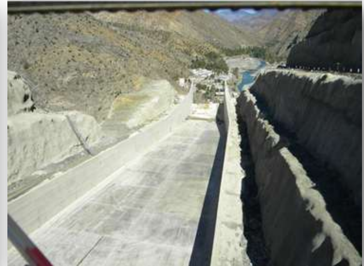
Dolusavak Shut Yapısı
