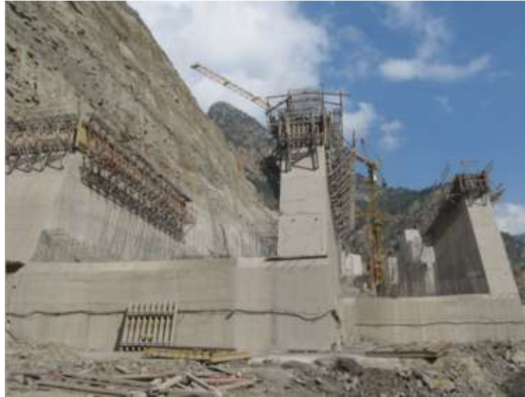
Ana Santral Binası Görünümü 2009 .... [ DOLSAR MÜH. LTD. ]
